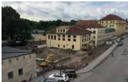
Baustelle des neuen Nano-Instituts
